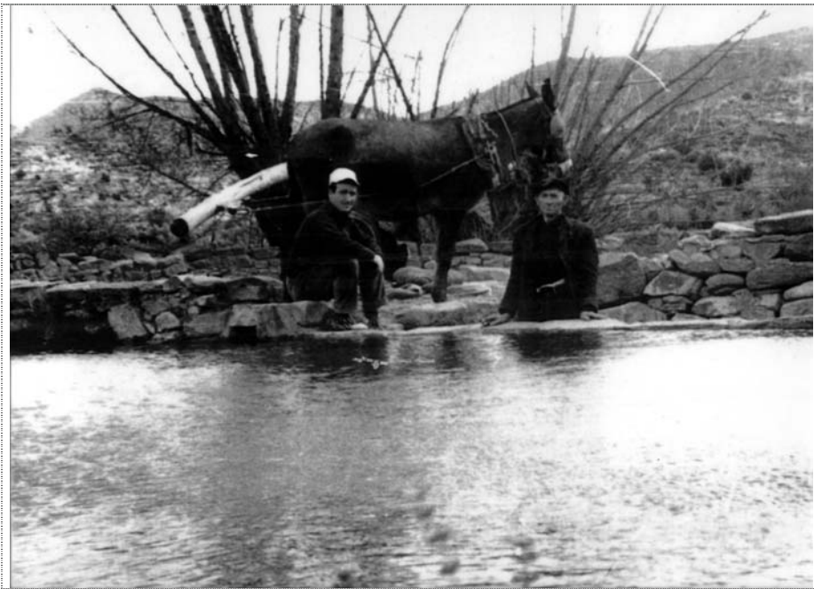
Foto I. Cenia de Azuébar en funcionamiento. Un alto en el trabajo.
